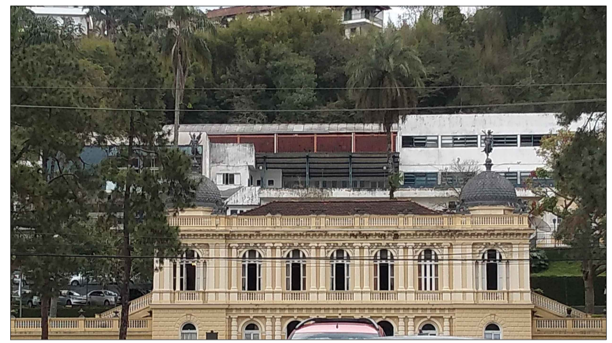
3 LICEU MUNICIPAL - FACHADA EXISTENTE SEM ESCALA
