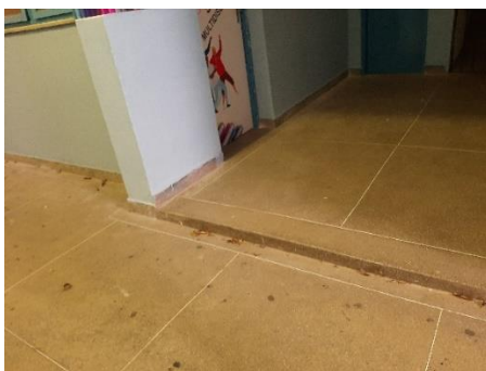
Fotos 07– Vista de um dos desníveis da circulação entre os blocos de salas de aula onde será considerado o nivelamento do piso
