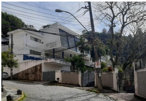
Foto 01– Fachada principal do Liceu Municipal Prefeito Cordolino Ambrósio vista da Rua Oscar Weinscheink
