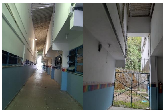
Fotos 05 e 06 – Corredor de interligação entre os blocos de salas de aula e respectivo local de construção da rampa de acesso ao pavimento superior (salas de aula e quadra poliesportiva)
