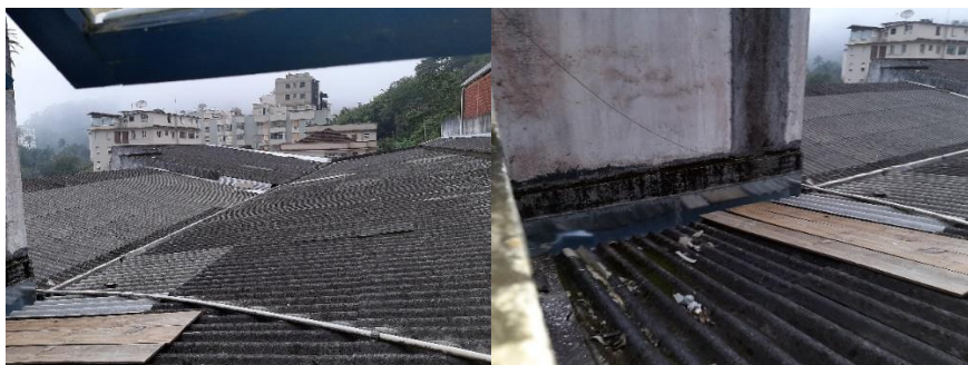
Fotos 24 e 25 – Estado geral dos telhados
