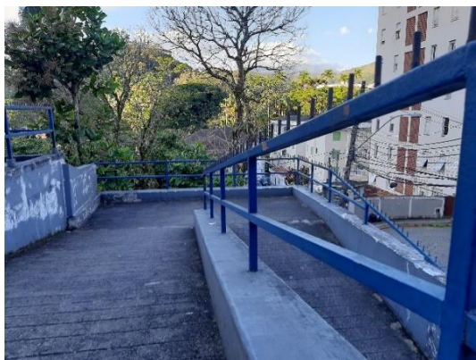
Foto 03 – Vista da Rampa de acesso Principal ao prédio do Liceu
