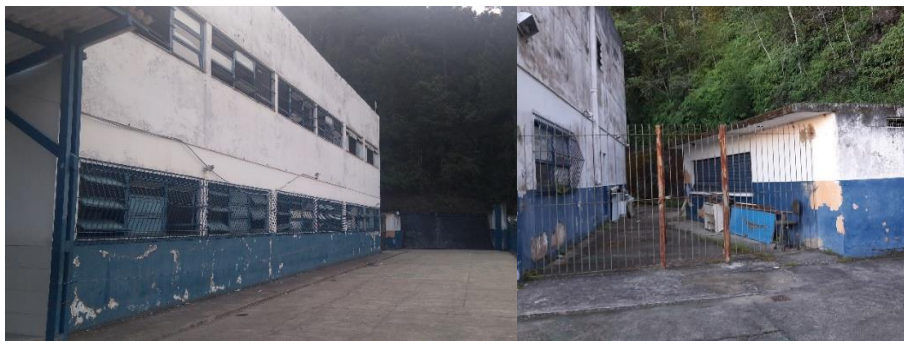
Fotos 18 e 19 – Vista do geral das fachadas do prédio
