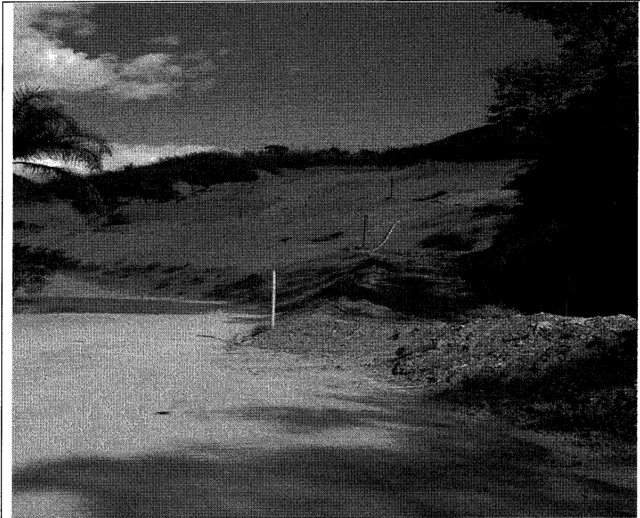
Área de Implantação da Barreira Hidráulica (BH 2)
