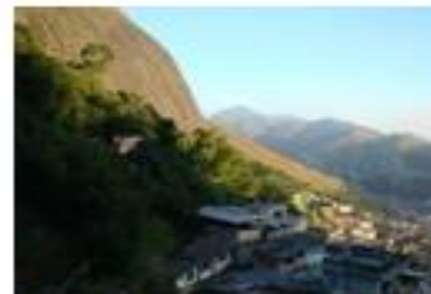
Foto 003 - Construções muito próximas ao maciço rochoso.
