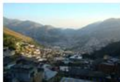
Foto 002 - Ocupação consolidada na encosta.
