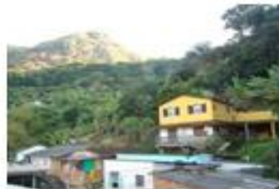
Foto 004 - Moradia construída no talvegue.
