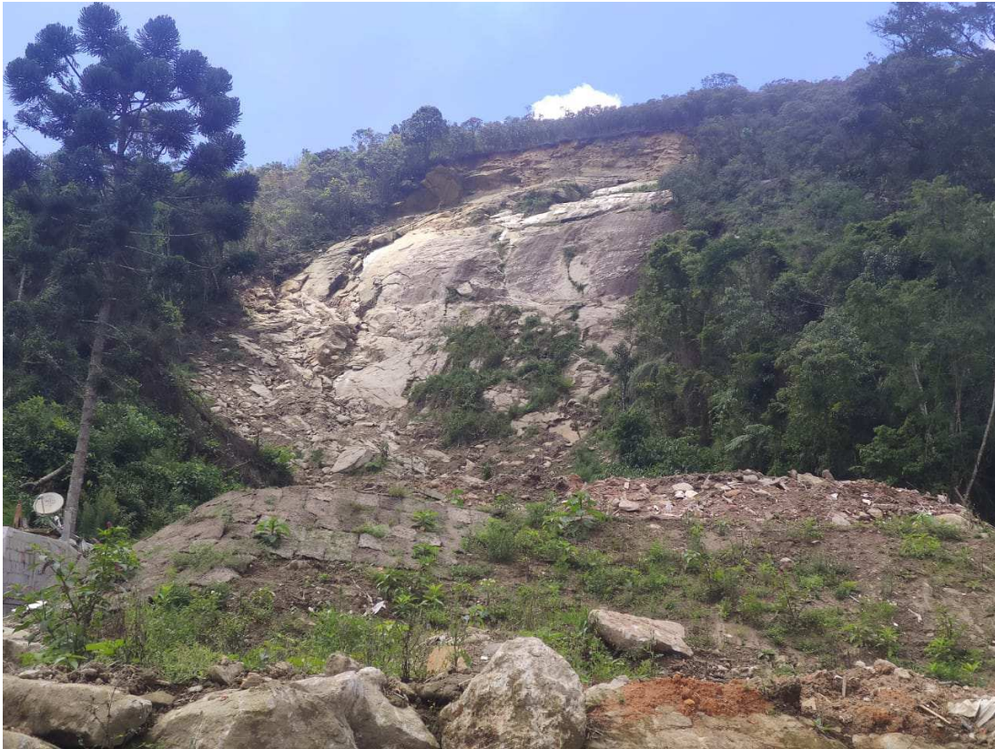
Figura 4 : Cenário 02 - Desmonte de blocos de rocha sã, em encosta, em carga em retro-escavadeira e transporte em caminhão para bota-fora licenciado.
