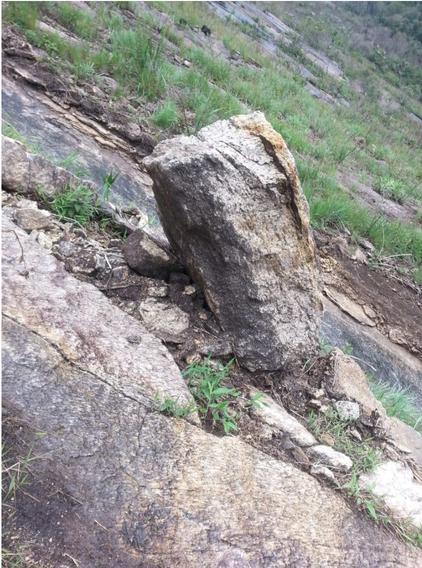
Figura 3 : Cenário 01 – Desmonte de blocos de rocha sã em encosta, com redução à pedras de mão, e acomodação em caixas de gabião.
