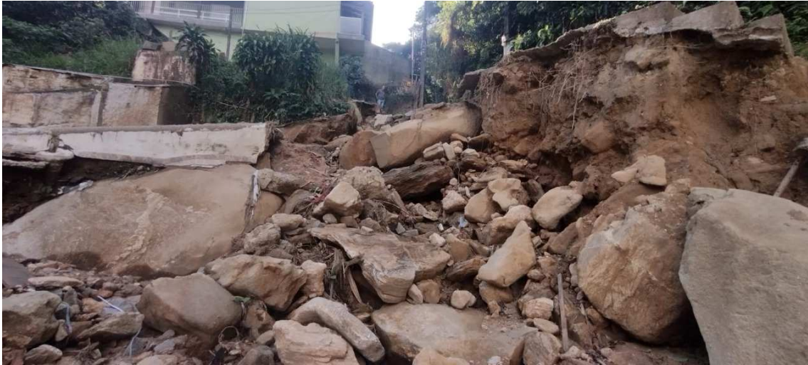
Figura 6 : Cenário 04 – Desmonte de Blocos de Rocha Sã, em leitos de rio e córregos, carga com escavadeira hidráulica, com transporte em caminhão. Bota-fora licenciado.
