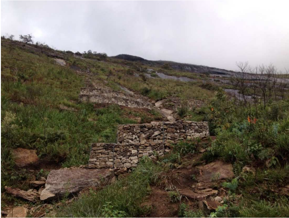
Figura 1 : Cenário 01 – Desmonte de blocos de rocha sã em encosta, com redução à pedras de mão, e acomodação em caixas de gabião.
