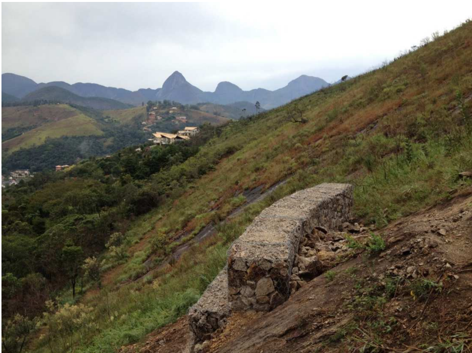
Figura 2 : Cenário 01 – Desmonte de blocos de rocha sã em encosta, com redução à pedras de mão, e acomodação em caixas de gabião.
