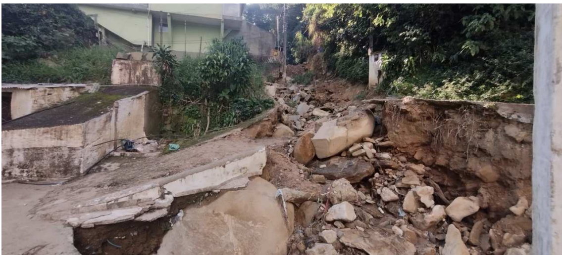
Figura 7 : Cenário 04 – Desmonte de Blocos de Rocha Sã, em leitos de rio e córregos, carga com escavadeira hidráulica, com transporte em caminhão. Bota-fora licenciado.
