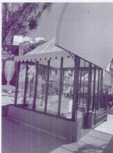
Vista da área interna
