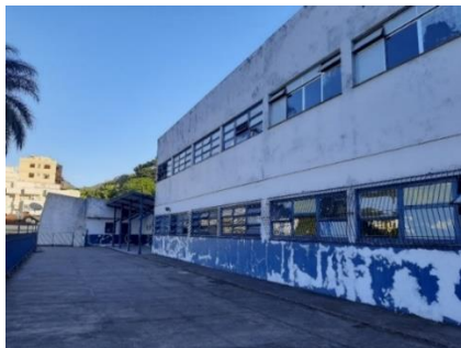
Foto 14 – Aspecto das esquadrias da fachada frontal do Liceu
