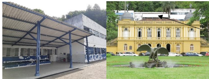
Fotos 11 e 12 – Cobertura existente na fachada frontal do Liceu a ser readequada para melhor ambientação da fachada com o entorno da Câmara Municipal e simulação da platibanda de alvenaria a ser construída no pátio escolar
