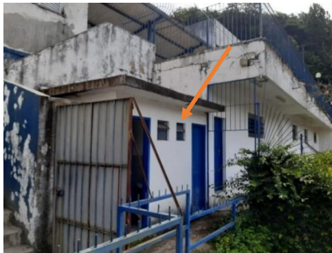
Foto 04 – Local dos sanitários a serem demolidos para implantação da plataforma elevatória de acesso ao 2º pavimento
