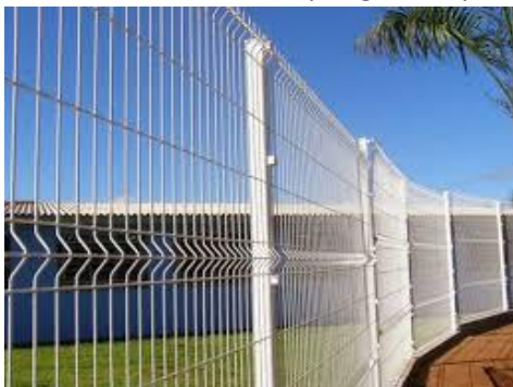
Fotos 26 – Exemplo de uso do gradil nylofor como cercamento e proteção
