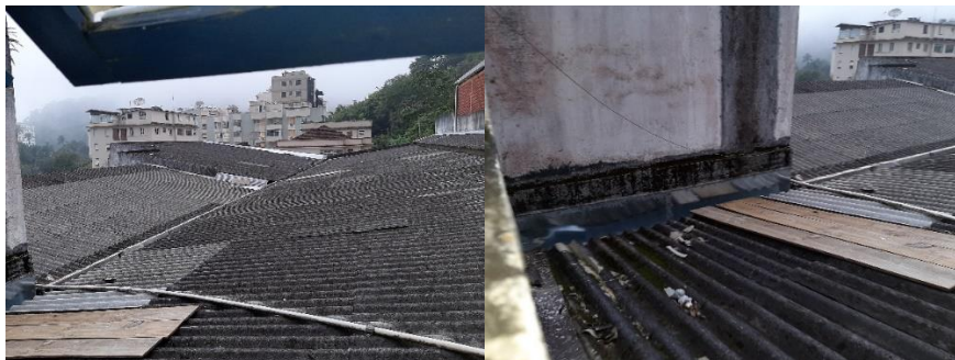
Fotos 24 e 25 – Estado geral dos telhados
