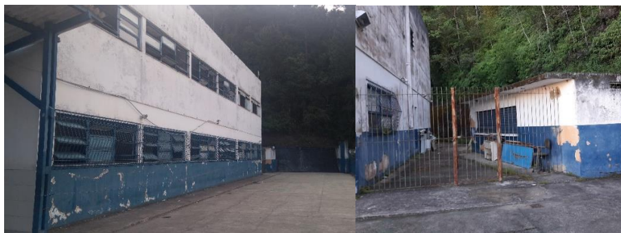
Fotos 18 e 19 – Vista do geral das fachadas do prédio
