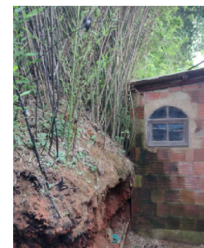
Local da obra (Vista de Jusante)
