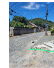
CALÇADA COM INCLINAÇÃO DE 2%
