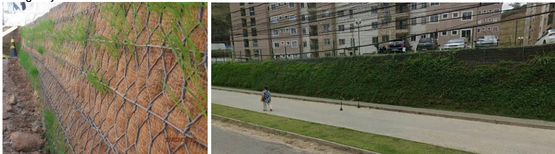
Fotos 01 e 02 – Exemplo de contenção em muro de solo reforçado Terramesh Verde. Fonte: https://www.gabioesbr.com.br / Theopratique Engenharia
