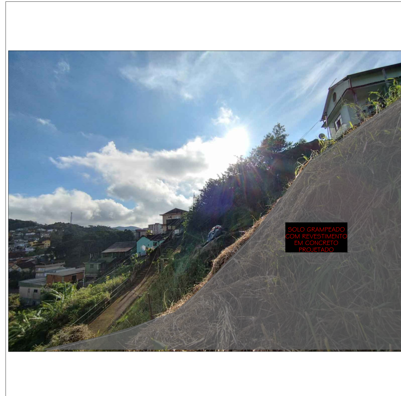
2 FIGURA 02 - CONCRETO PROJETADO SEM ESCALA
