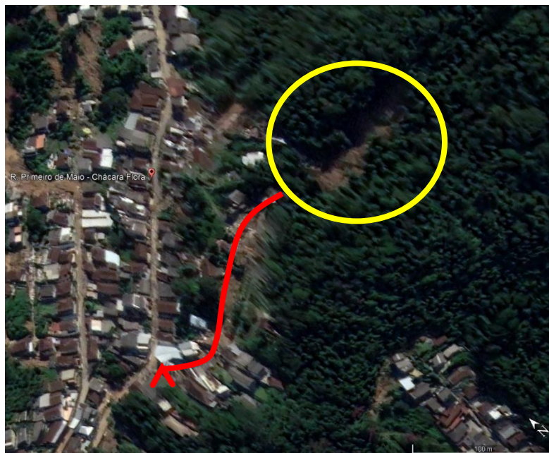
Figura 1 : Origem do escorregamento na Rua Primeiro de Maio, datado de Fevereiro/2022 (segue em anexo a imagem no final do projeto)
