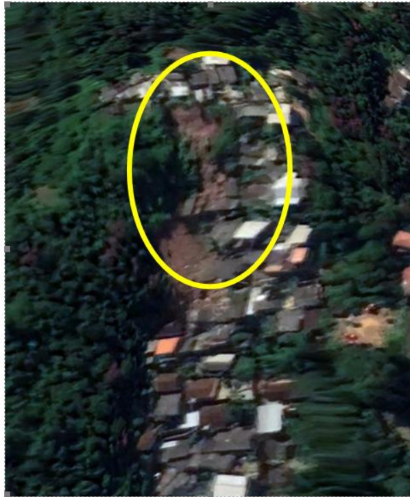
Figura 1 : Origem do escorregamento na Rua Itália, datado de Fevereiro/2022.
