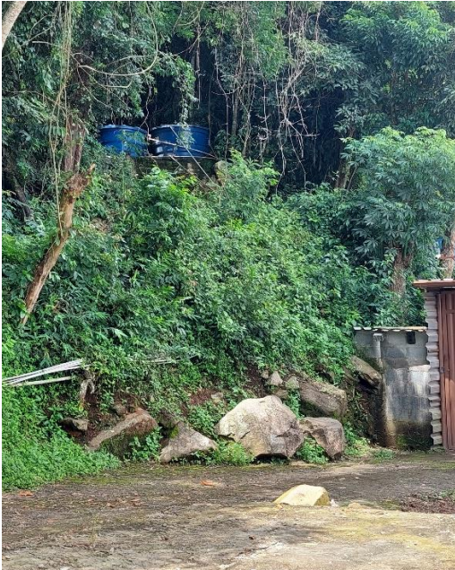
Fotos 11 e 12: Imagens exibindo blocos e/ou lascas de rocha deslizados e depositados no sopé do talude e a interação destes blocos com a ocupação humana ali instalada
