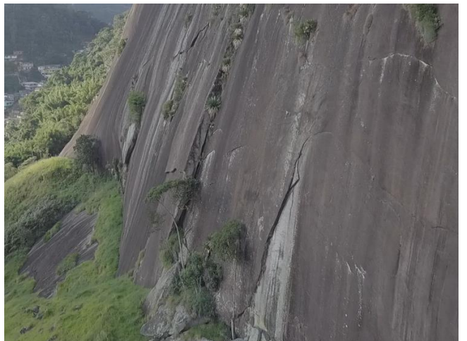
Fotos 05 a 08: Imagens obtidas via drone, exibindo fraturas formando lascas (foto 05), ninhos de blocos (foto 06) e lascas de alívio (foto 07 e 08), distribuídos ao longo da face do talude rochoso
