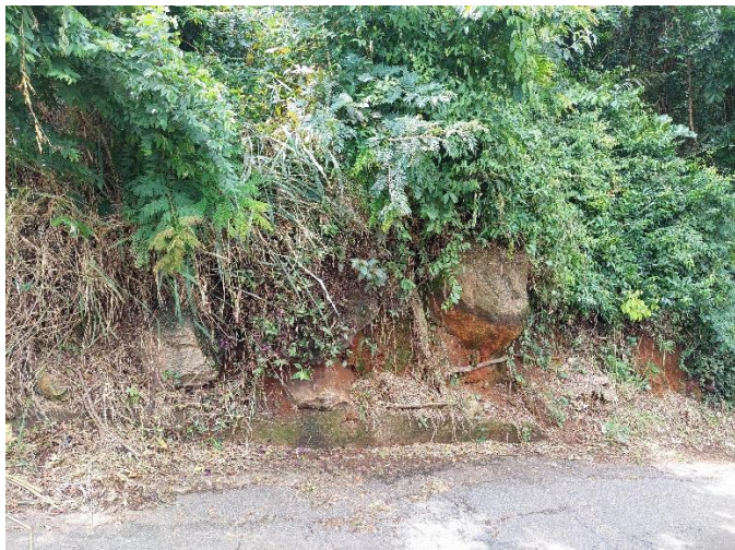
Fotos 01 e 02: Imagens exibindo blocos e/ou lascas de rocha deslizados e depositados no sopé do talude, de volumes variados, estando imersos solo transportado heteroforme em relação a sua granulometria e composição
