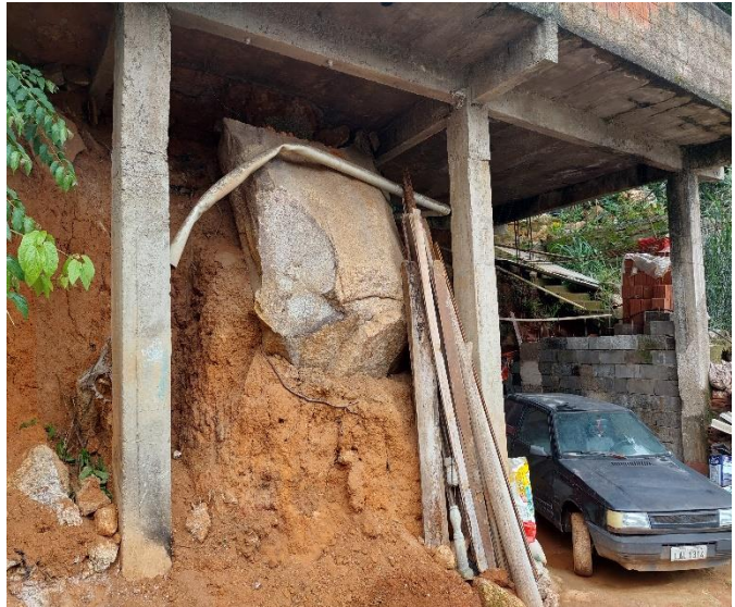
Fotos 11 e 12: Imagens exibindo blocos e/ou lascas de rocha deslizados e depositados no sopé do talude e a interação destes blocos com a ocupação humana ali instalada
