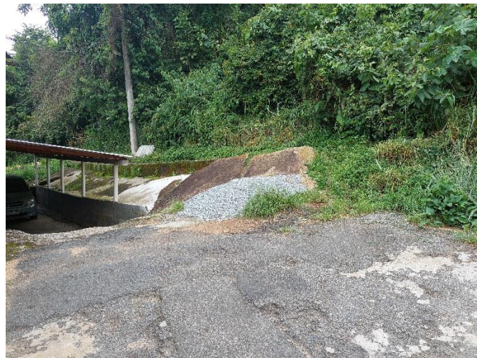
Fotos 01 e 02: Imagens exibindo blocos e/ou lascas de rocha deslizados e depositados no sopé do talude, de volumes variados, estando imersos solo transportado heteroforme em relação a sua granulometria e composição
